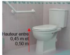
2- Avec la cuvette, il faut une barre d'appui sur son côté afin d'assurer une sécurité pour des personnes en incapacité et permettre le transfert de l'utilisateur circulant en fauteuil sur la cuvette (hauteur comprise entre 0,70m et 0,80m). Mais il faut aussi pouvoir se relever. C'est pourquoi il faut une barre complémentaire, qui assure cette fonction. 2 choix de positionnements possibles :
