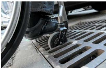
Cela permet d'éviter que la roue d'un fauteuil se bloque ou que la canne passe dans les trous ou fentes.
